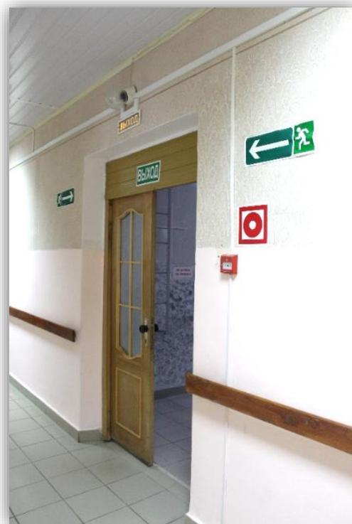
В соответствии с требованиями пожарной безопасности здание оборудовано: автоматической пожарной сигнализацией, речевым оповещением, пожарными кранами,
